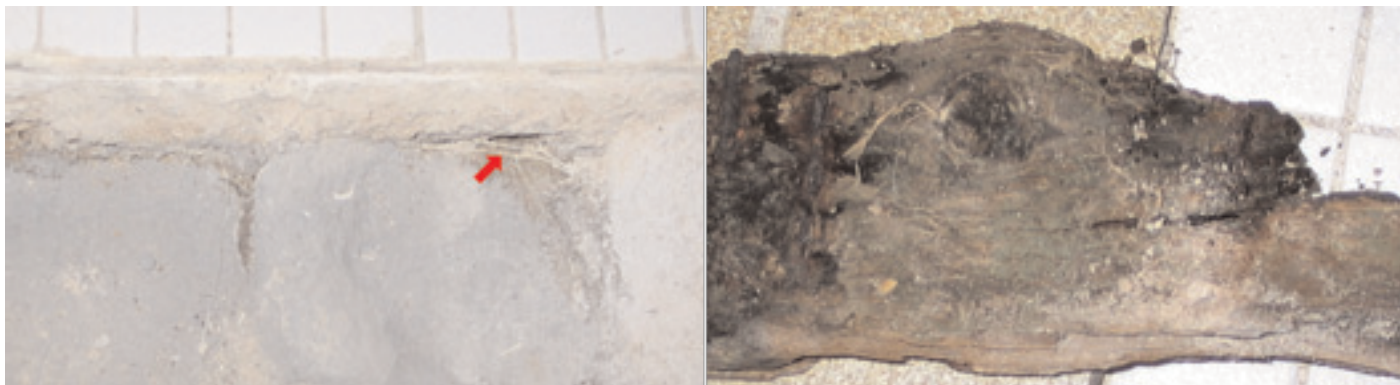
Ein typisches Schadenbild beim Befall durch den Echten Hausschwamm: Der Fußboden des Badezimmers war hier bereits von Myzelsträngen (siehe Pfeil) durchwachsen und musste komplett freigelegt und behandelt werden. Rechts: Das verbaute Holzstück aus dem Souterrain wurde durch den Schwamm stark zersetzt.
