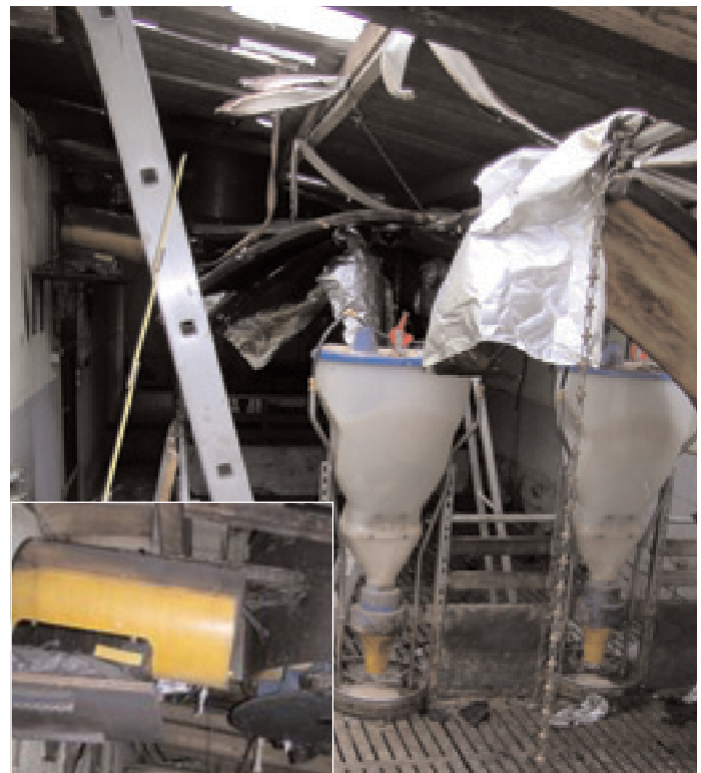
In dem Stall im ersten Stock waren rund 100 Tiere untergebracht. Kleines Bild: Der zweite Gasheizler stand auf einer etwas größeren Konsole als das betroffene Gerät. Foto: IFS
