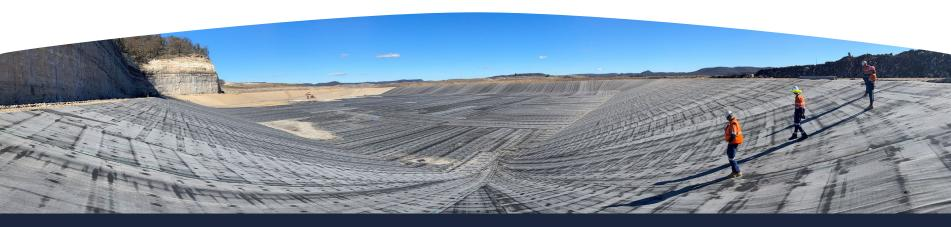
BITUMINOUS GEOMEMBRANE FOR ENVIRONMENTAL PROTECTION AND LANDFILL CAPPINGS
