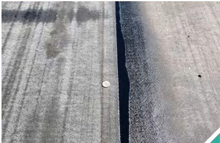
▲ Bitumen overflow
